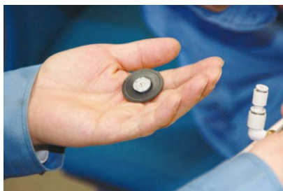
実際に減圧弁を分解して中のダイヤフラムを交換しました。内部構造がよくわかりました。
